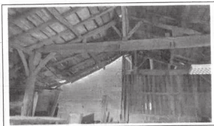
Charpente vétuste et nature hétéroclite des parois qui la bordent. Murs en parpaings, en pierres sèches et séparation en bardage bois.
