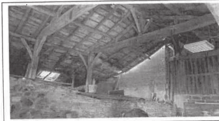
Charpente vétuste et nature hétéroclite des parois qui la bordent. Murs en parpaings, en pierres sèches et séparation en bardage bois.
